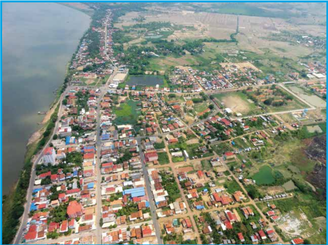
រូបភាពទី ១៩ ៖ ទិដ្ឋភាពពីលើអាកាសនៃភូមិឋានក្នុងក្រុងក្រចេះ រួមជាមួយនឹងផ្លូវដើរលំហែតាមដងទន្លេមេគង្គ (ខាងឆ្វេង) ទីធ្លាបៃតង និងបឹងរំលេច (ខាងស្តាំ) ។ (ប្រភព៖ Smith, 2014)
