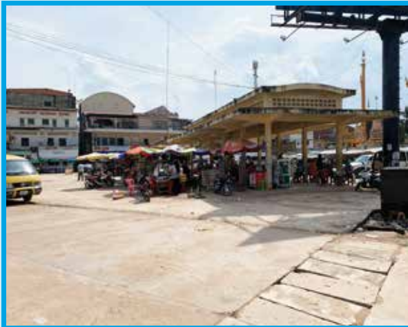
រូបភាពទី ៣១ ៖ ឧទាហរណ៍នៃការបិទផ្ទៃដោយបេតុងនៅបេនឡានក្រុងក្រចេះ (ប្រភព៖ រូបថតផ្ទាល់ខ្លួន ថតក្នុងឆ្នាំ ២០២៣)
