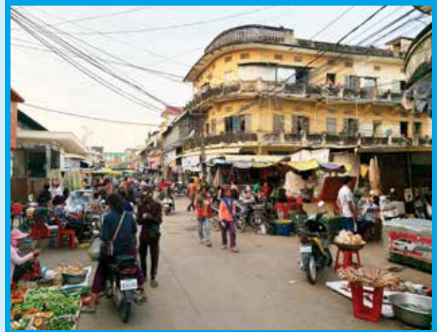
រូបភាពទី ៣២ ៖ ឧទាហរណ៍នៃការបិទផ្ទៃដោយបេតុងនៅផ្សារក្រុងក្រចេះ (ប្រភព៖ រូបថតផ្ទាល់ខ្លួន ថតក្នុងឆ្នាំ ២០២៣)
